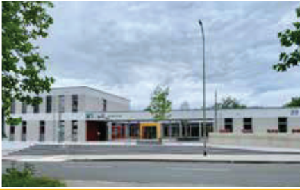
Kinder- und Familienzentrum Dalheim. Adresse: Berliner Ring 39, 35576 Wetzlar. Hinweis: Bitte nutzen Sie den linken Eingang (neben der roten/orangenen Hauswand).
