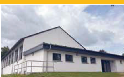
Turnhalle Grundschule Steindorf-Albshausen. Adresse: Schulstraße 28 B, 35579 Wetzlar.
