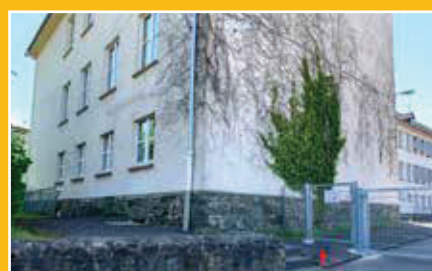
Lotteschule Keller / Keramikraum. Adresse: Kestnerstraße, 35578 Wetzlar. Hinweis: Die Keramikräume befinden sich im Keller der Lotteschule. Dieser ist lediglich über die Kestnerstraße (Gebäuderückseite, nicht über den Haupteingang in der Frankfurter Straße!) zugänglich. Vor dem Tor direkt links die Treppe runter gehen.
