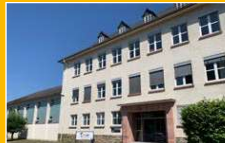
Lotteschule Turnhalle. Adresse: Frankfurter Str. 25, 35578 Wetzlar. Hinweis: Die Turnhalle der Lotteschule ist lediglich über den Haupteingang zugänglich. Bitte nutzen Sie nicht den Weg über den Schulhof. Dieser ist videoüberwacht und gesperrt!
