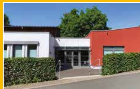
Kinder- und Familienzentrum Niedergirmes. Adresse: Fröbelstraße 3, 35576 Wetzlar. Hinweis: Bitte nutzen Sie den rechten Eingang (neben der roten/orangenen Hauswand). Der Gymnastikraum befindet sich hier rechts.
