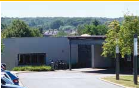
Friedrich-Fröbel-Schule Turnhalle. Adresse: Franzenburg 6, 35578 Wetzlar. Hinweis: Bitte gehen Sie vom Parkplatz aus links am Schulgebäude vorbei durch den Glasdurchgang und den Innenhof in Richtung Turnhalle. Der Haupteingang rechts führt nicht zur Halle.
